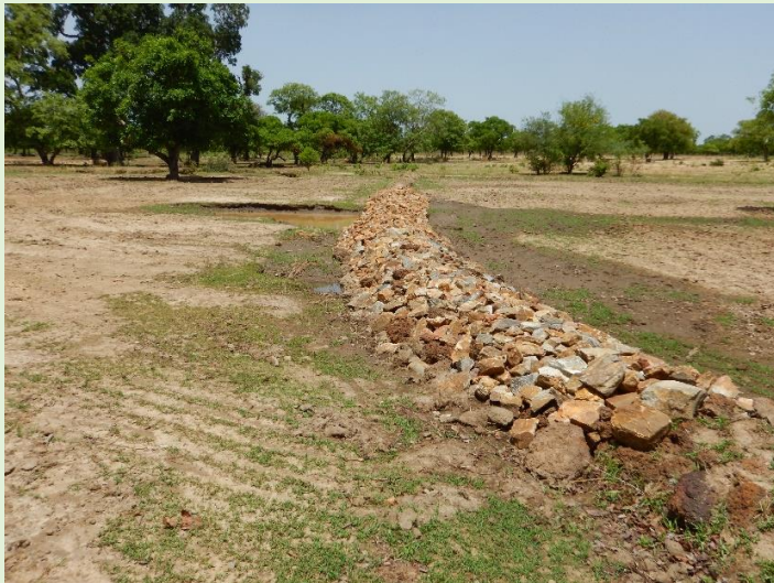
Une diguette enrochée dans le cadre de la confortation de bas fond
