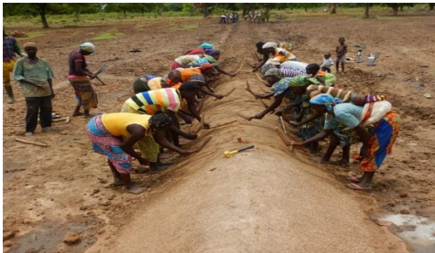
1 : Construction de diguette principale de bas-fond
