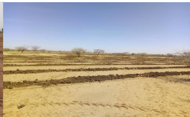
4 : Récupération mécanique de terre
